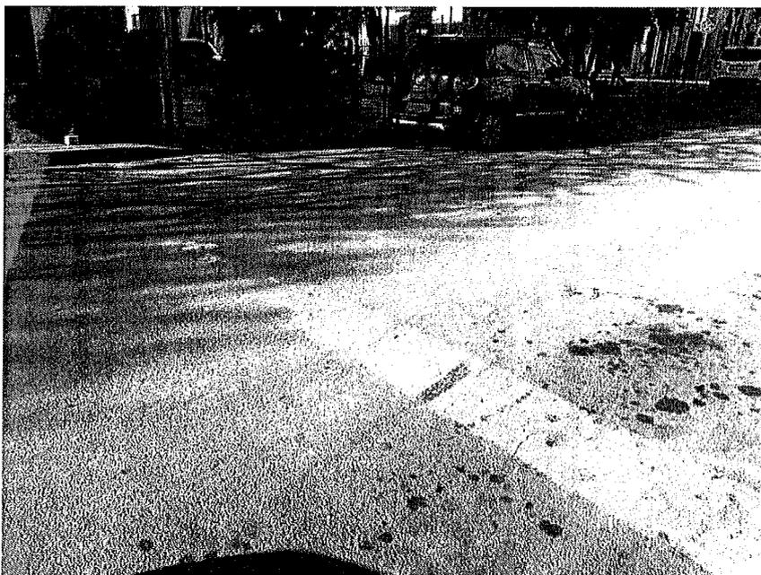
Ci si riferisce alle strisce pedonali e alle linee dello **stop**, quella striscia bianca disegnata sull'asfalto subito prima di un **semaforo**. **Praticamente, quasi inesistenti probabilmente a causa del continuo transito di veicoli** che, di certo, non aiuta al mantenimento delle strisce. Sarebbe il caso di **"raffozzarle"** e renderle visibili anche ai cecati.
