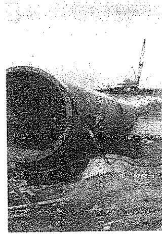
TRANI Condotta sottomarina
