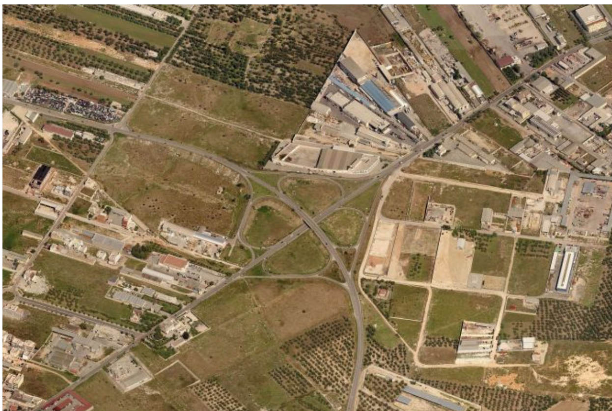
Svincolo tangenziale – Via Trani
